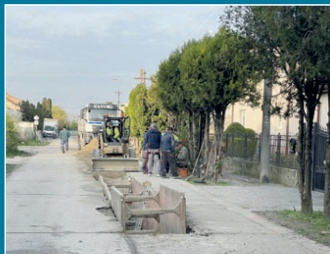
Budovanie kanalizácie by malo byť ukončené do konca roka 2023
