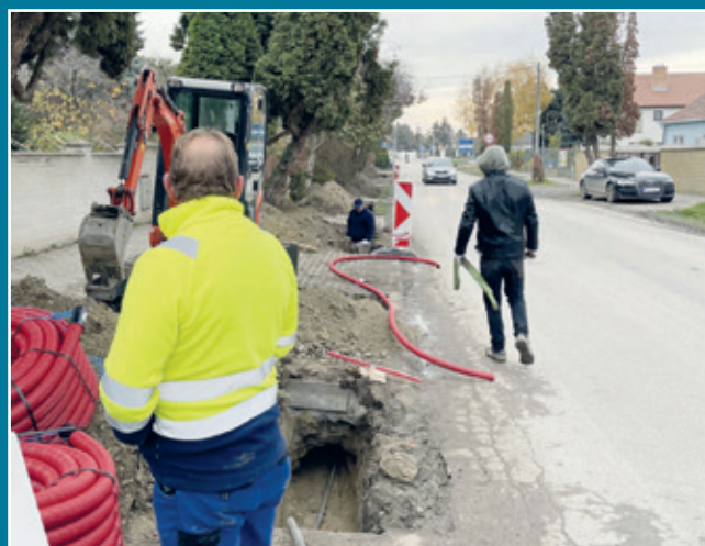
Budovanie optickej siete v obci
