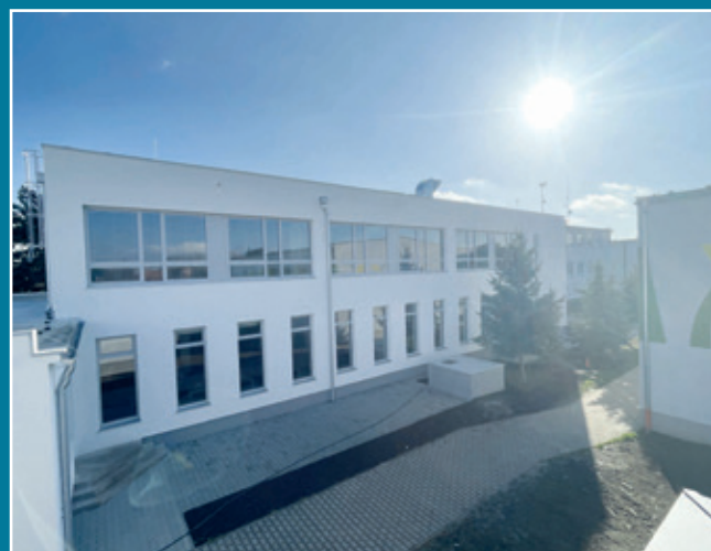
Dokončená prístavba budovy ZŠ
