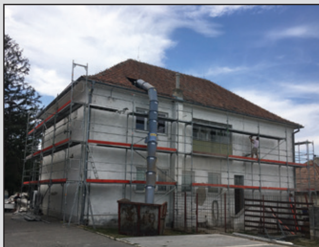
Rekonštrukcia budovy OÚ
