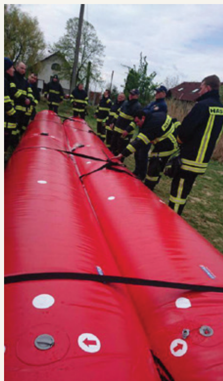
Stavanie protipovodňovej steny.
