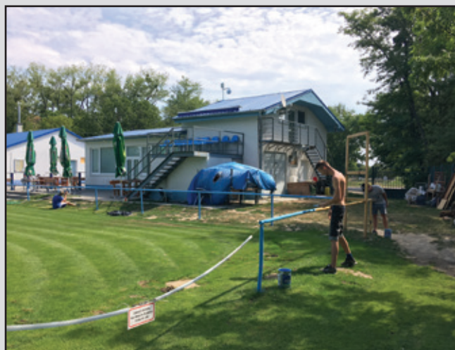
Obnova náterov v rámci objektov v obci
