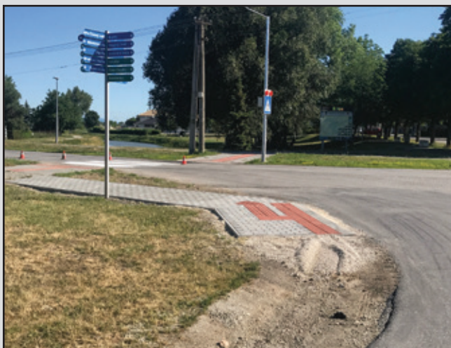
Výstavba nových úsekov chodníkov. Jurajov dvor, oproti ZŠ a pri kostole sv. Jána.
