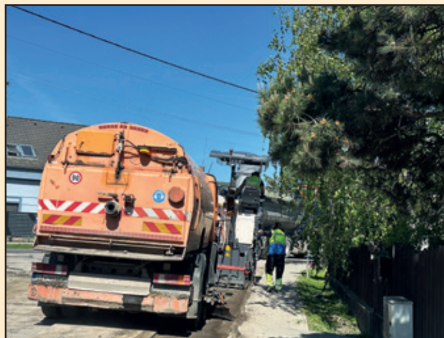
Výstavba kanalizácie finalizuje
