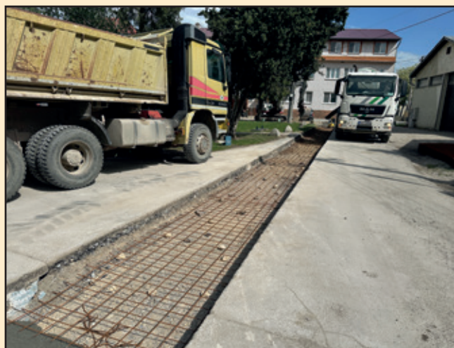
Úpravy ciest v rámci výstavby kanalizácie
