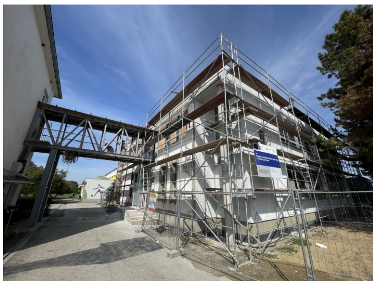
Prístavba základnej školy
