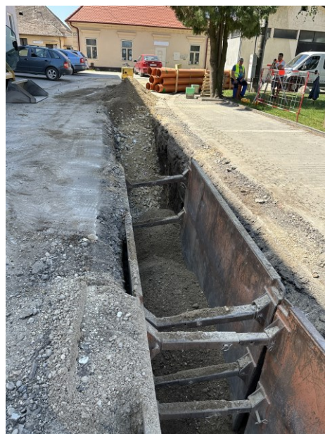
Budovanie kanalizácie
