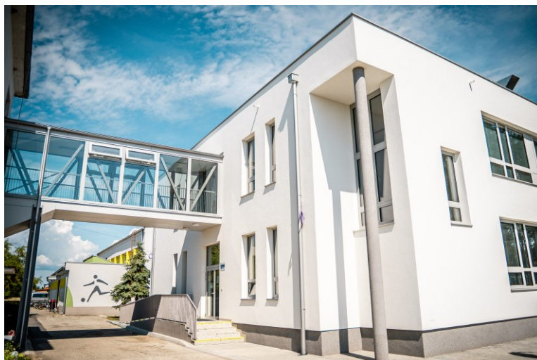
Prístavba základnej školy
