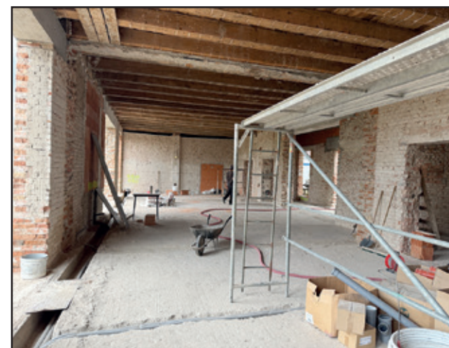
Rekonštrukcia Obecného domu
