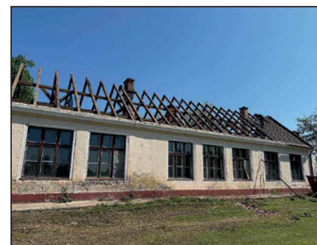
Rekonštrukcia Obecného domu- výmena strechy
